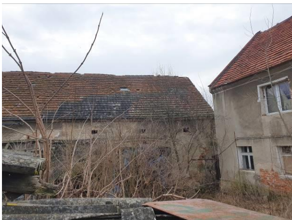
Zdjęcie. Widok budynku gospodarczego.
