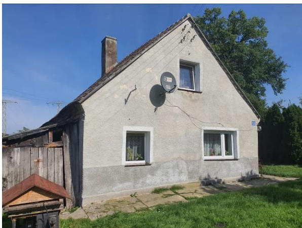
Zdjęcie. Widok budynku.
