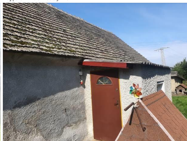
Zdjęcie. Widok budynku.
