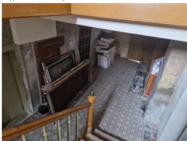
Zdjęcie nr 3. Widok klatki schodowej
