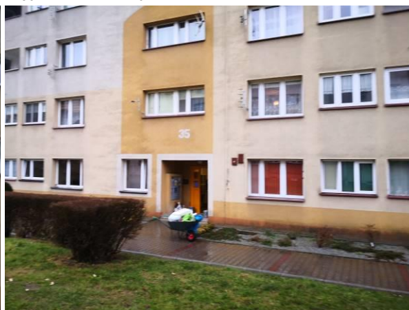
Zdjęcie 4 Widok budynku.
