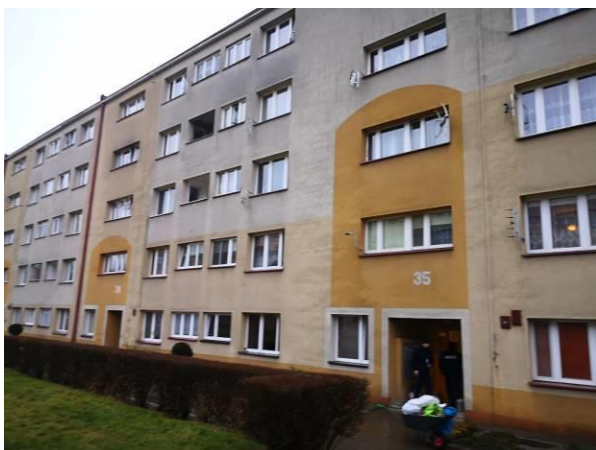
Zdjęcie 1 Widok budynku.
