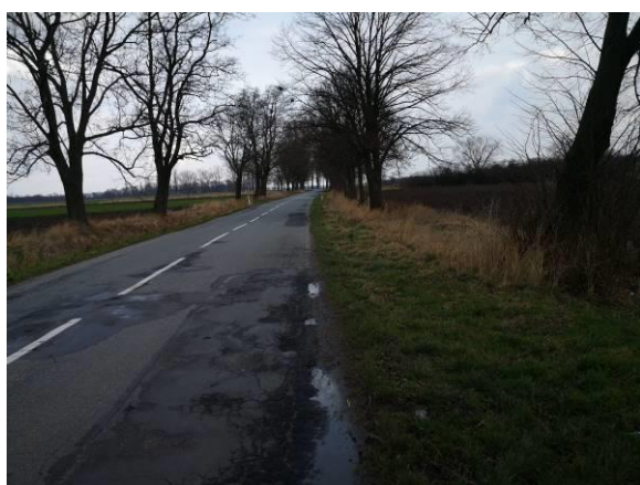
Zdjęcie nr 3. Widok drogi dojazdowej.
